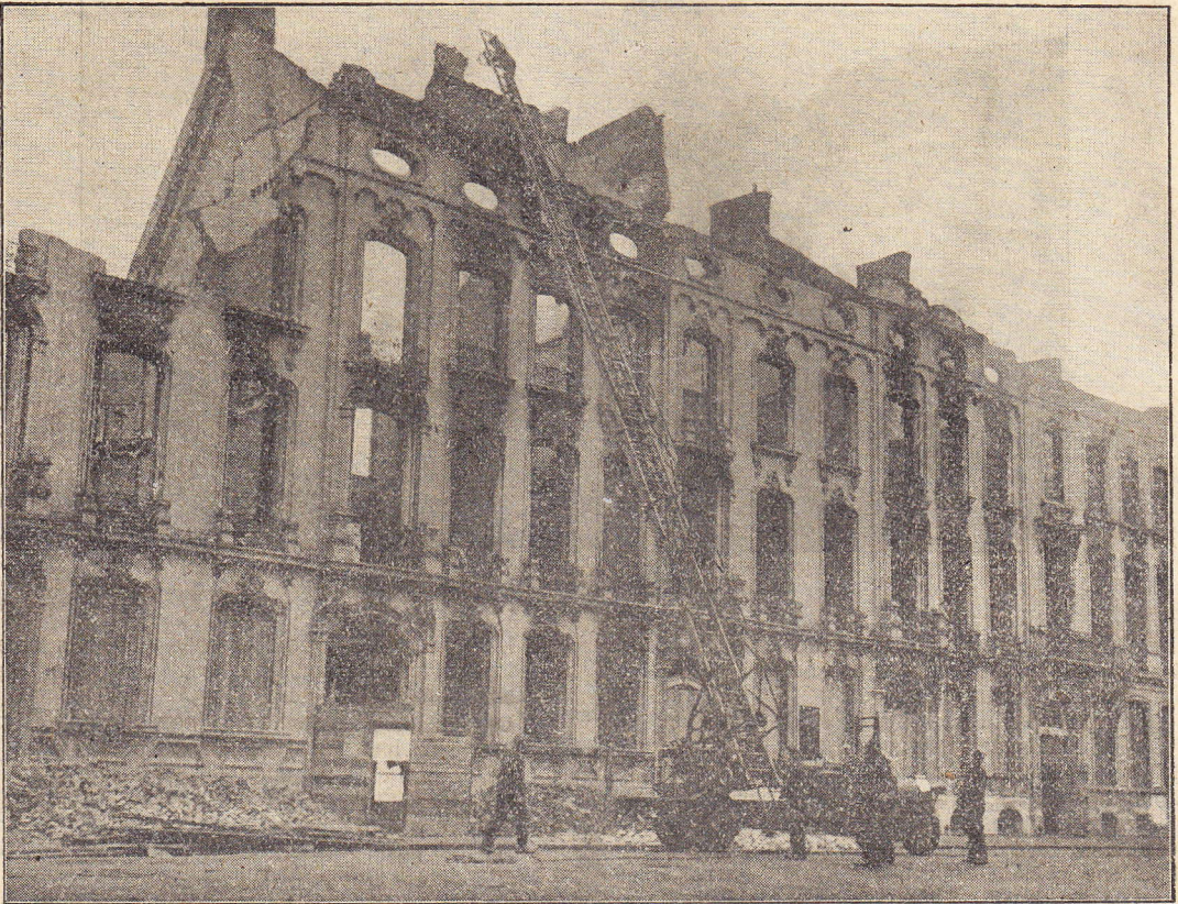
Les maisons détruites de la rue Van Bree à Anvers.
